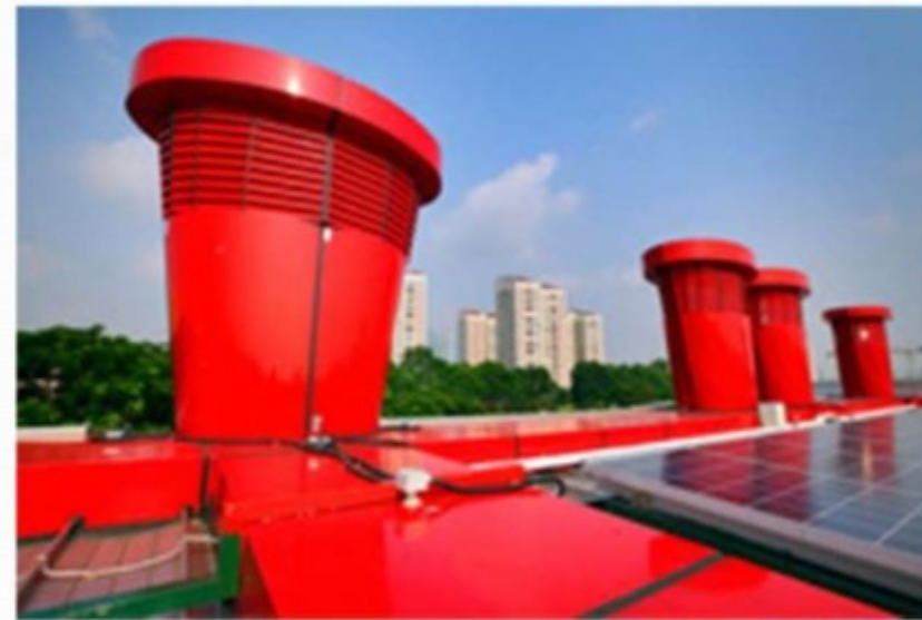
ترکیب سیستم تهویه طبیعی و سلولهای فوتوولتائیک
