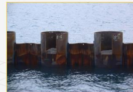
Sheet Pile & King Pile
