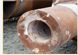
شمع فولادی با Pile Shoe
