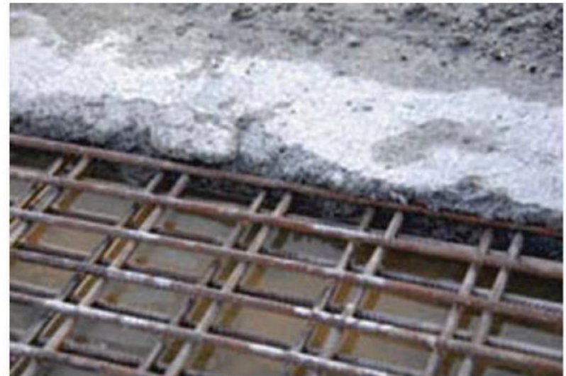
بهبودی دال با استفاده از افزایش ضخامت از بالای آن
