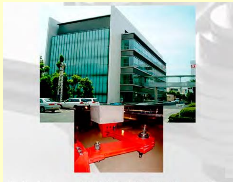
بهبود قابل توجه عملکرد Base Isolation با بکارگیری همزمان با میراگرها
