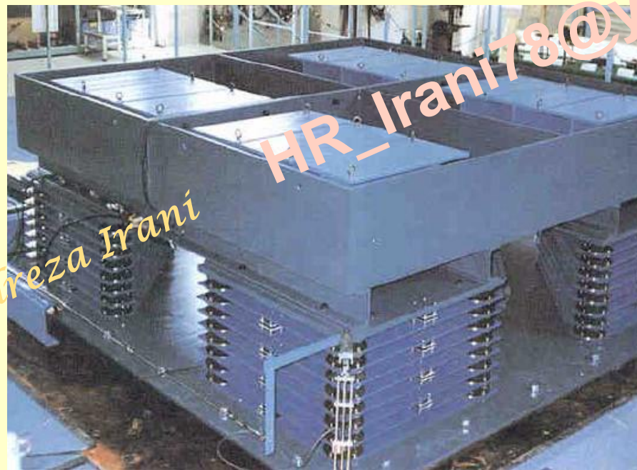
نمونه ای از TMD های جدید در برج Ten Bosch ناگاساکی
