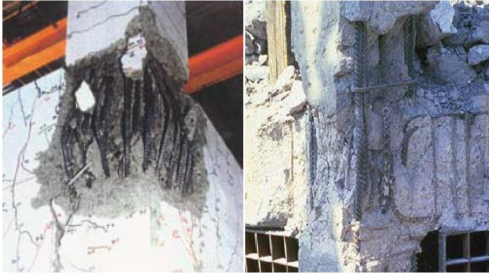
کمانش میلگردهای طولی ستون در ناحیه اتصال
