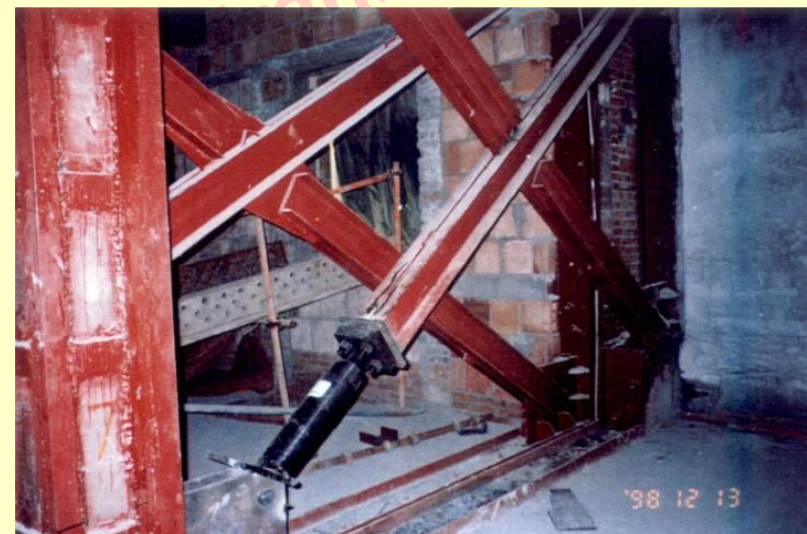
استفاده از میراگرهای ویسکوز در بادبندهای قطری
