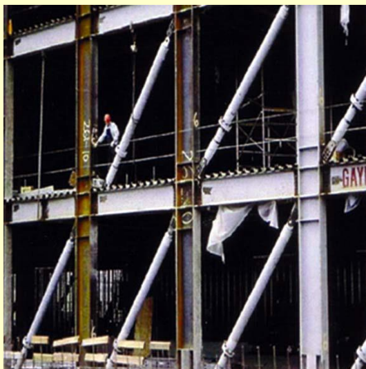
استفاده از میراگرهای ویسکوز در بادبندهای قطری
