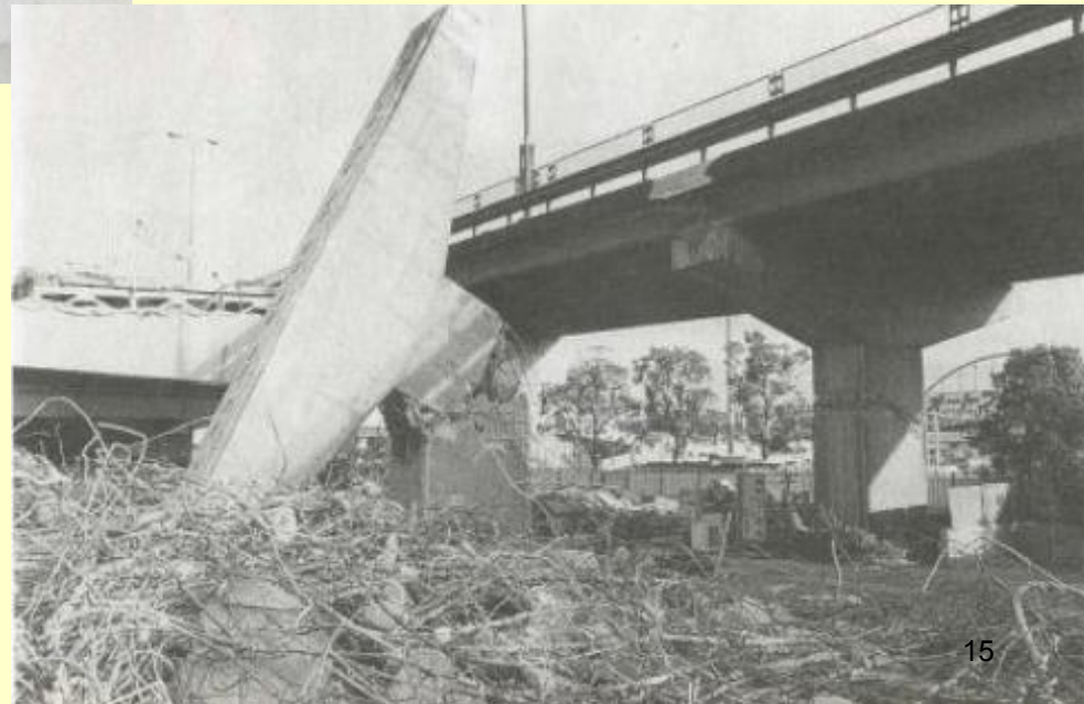
شکست خمشی - برشی پایه زلزله ۱۹۹۵ کوبه
