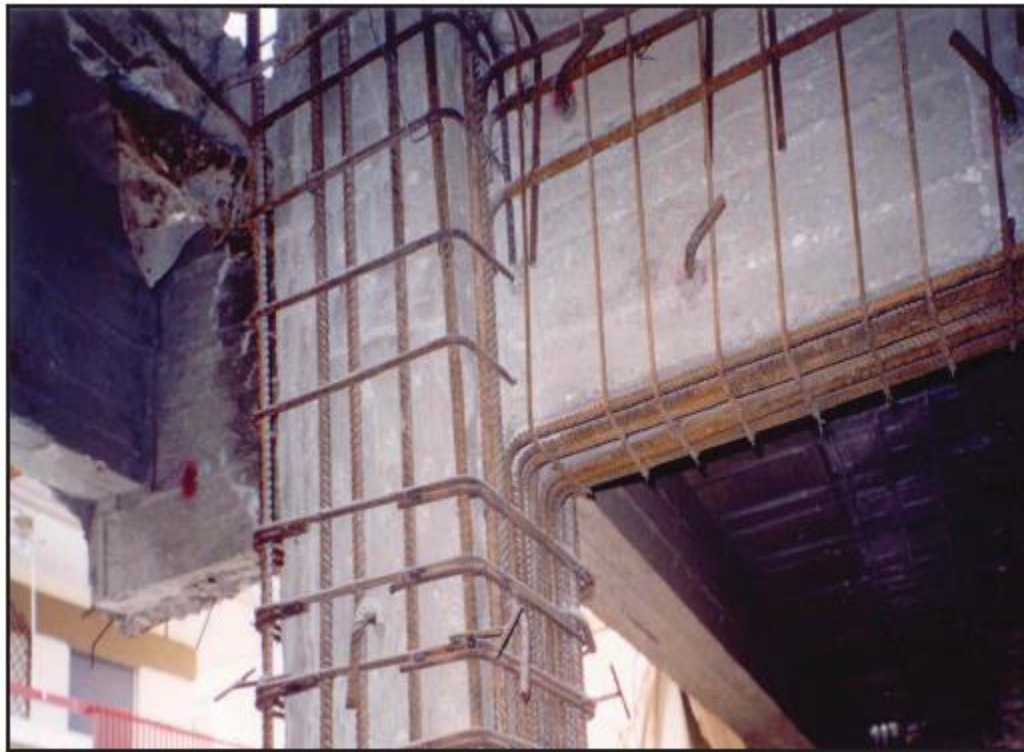
اجرای روکش بتنی در اطراف اتصال خارجی
