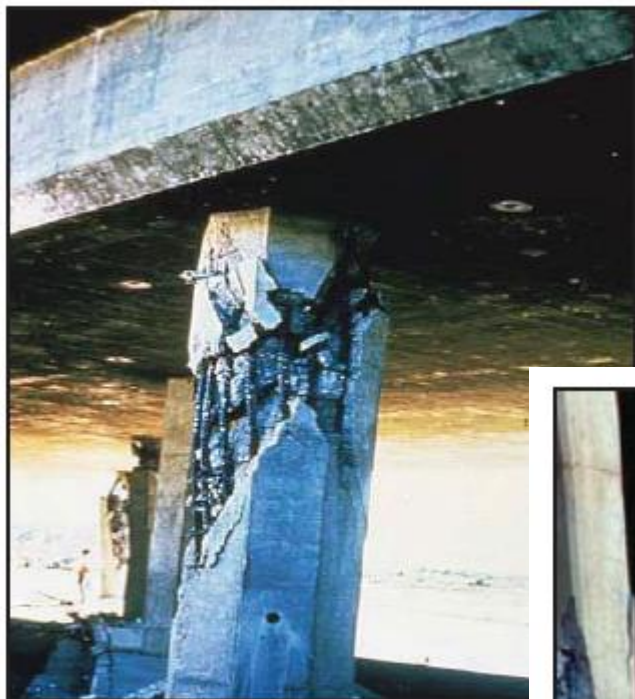
نمونه‌ای از شکست برشی ستون
