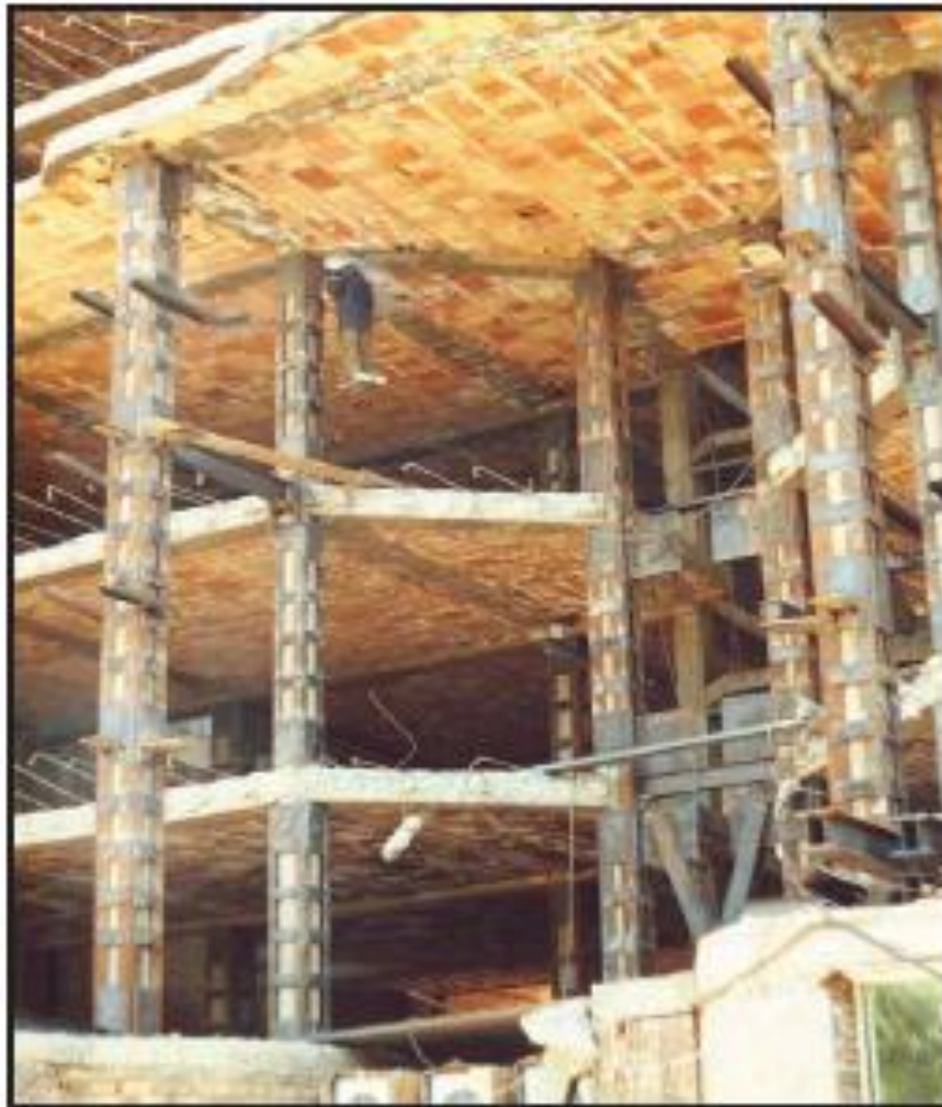
بهسازی ستونهای بتنی بوسیله ژاکت فولادی قفسه‌ای
