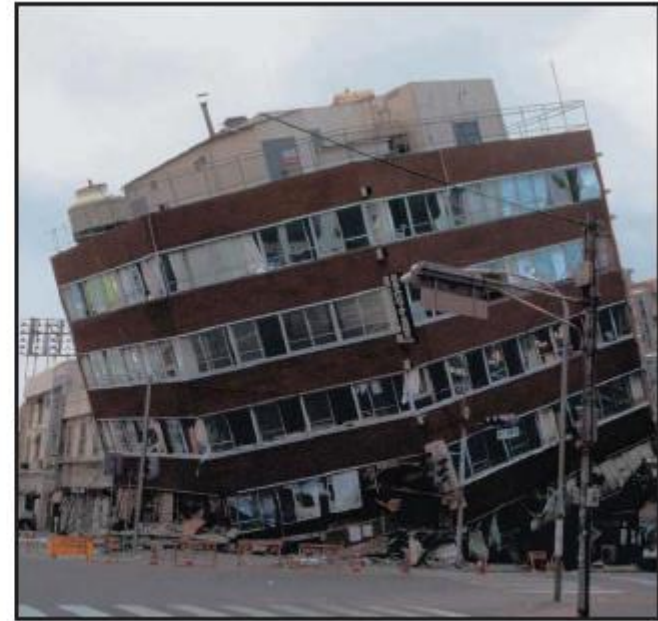
فاصله زیاد بین مرکز جرم و مرکز سختی و خرابی ناشی از ایجاد پیچش
