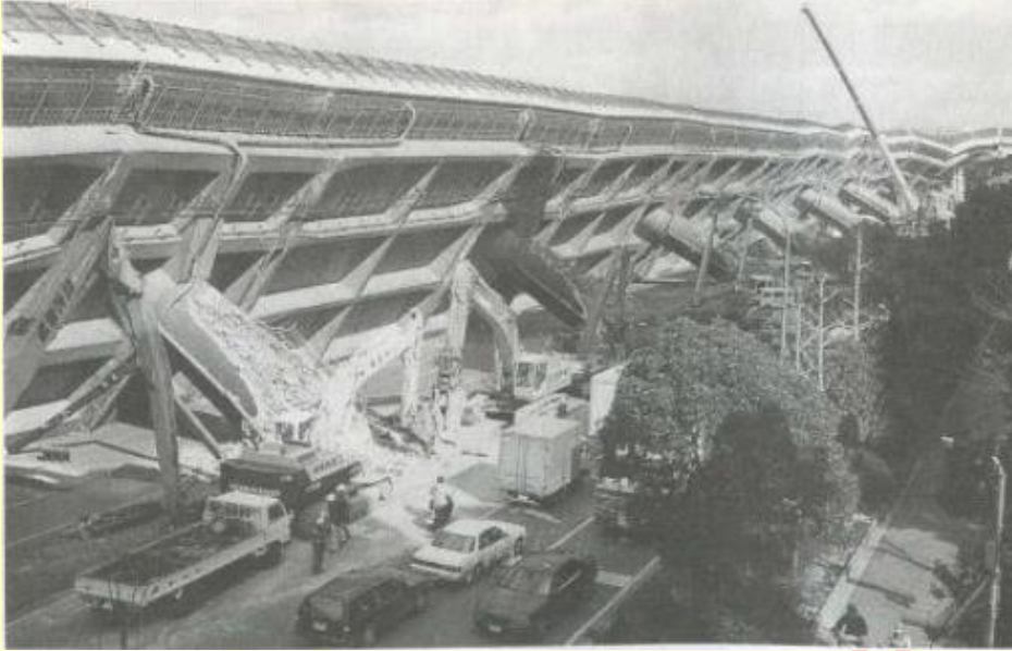
شکست خمشی ستونهای پل بزرگراه هانشین زلزله ۱۹۹۵ کوبه
