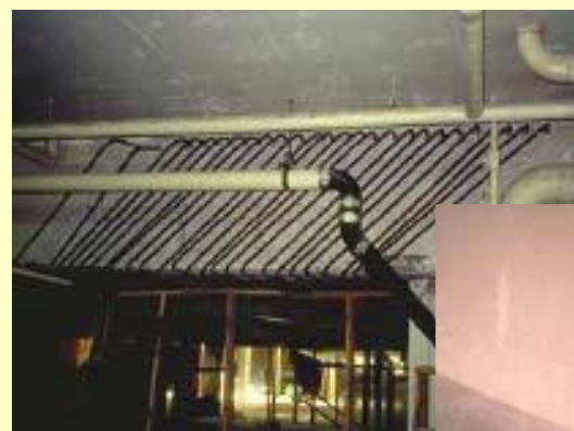
اجرای ژاکت بتنی برای افزایش مقاومت تیرهای بتنی
