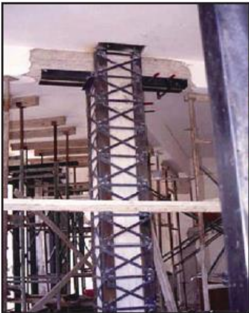
بهسازی ستونهای بتنی بوسیله ژاکت فولادی قفسه‌ای
