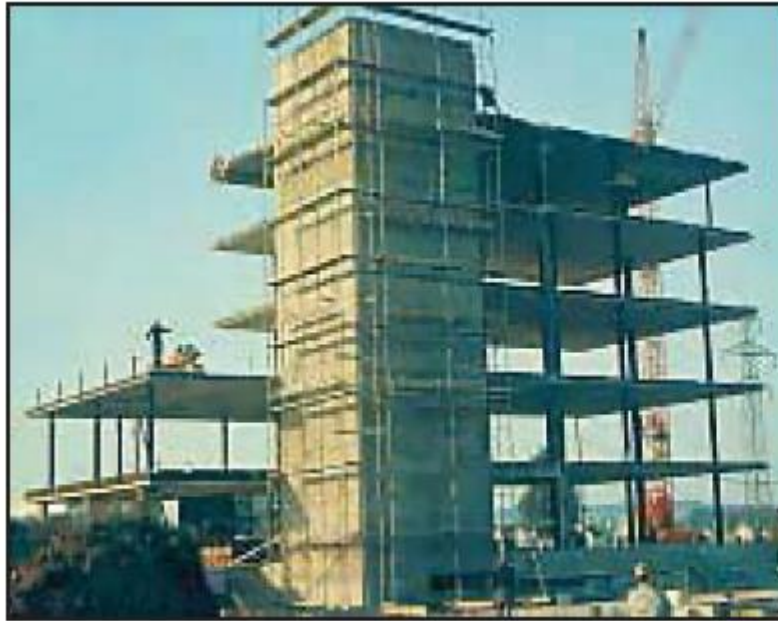
فاصله زیاد بین مرکز جرم و مرکز سختی و خرابی ناشی از ایجاد پیچش
