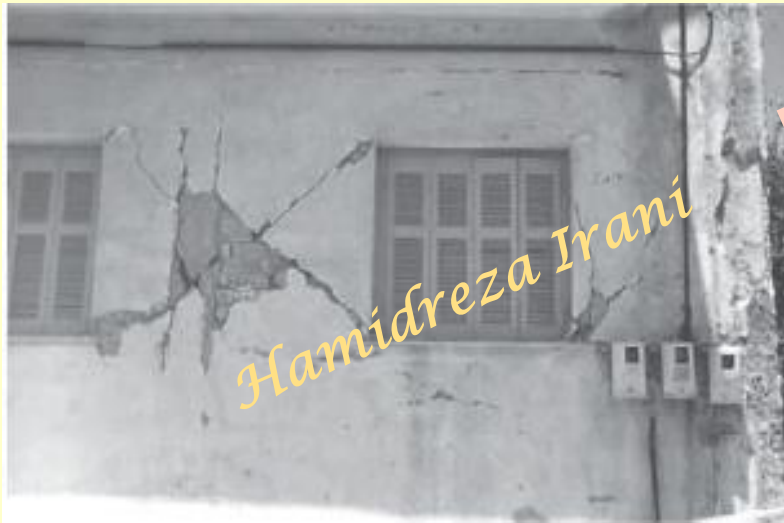
شکست برشی ستون کوتاه با وجود دیوارهای کنار بازشوها
