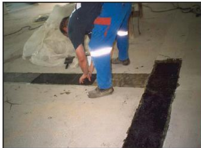
تقویت دال با استفاده از نوارهای FRP در نواحی لنگر منفی
