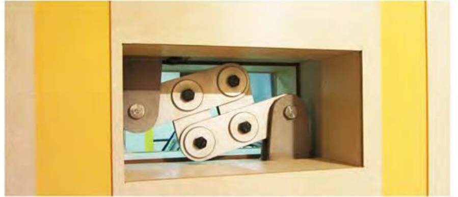
میراگرهای اصطکاکی - دورانی پانلی
