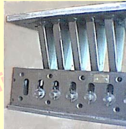
میراگر T-ADAS
