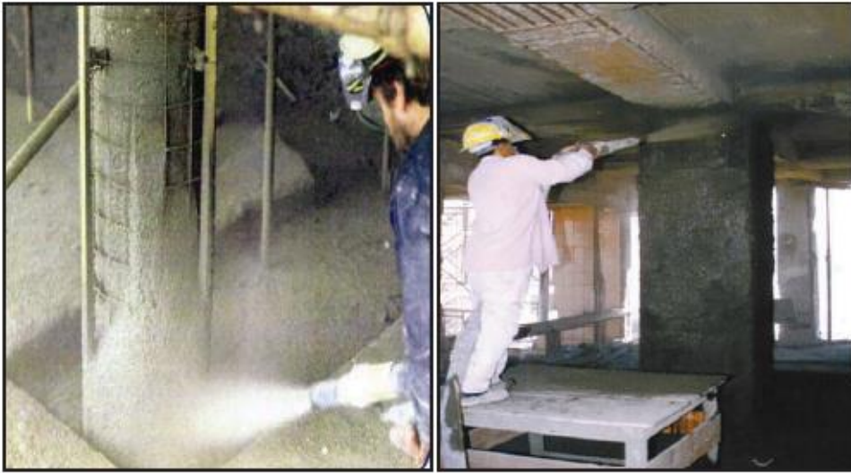
ژاکت بتنی با استفاده از بتن پاشی
