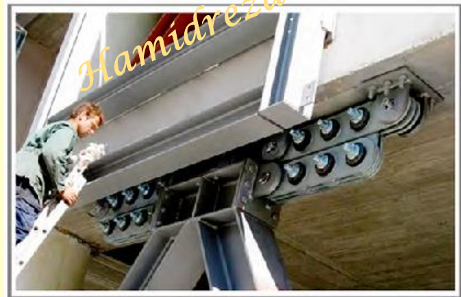
میراگر بکارفته در مهاربند قطری - شیلی
