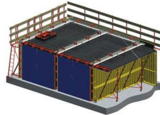
۳. اجراء شبکه آرماتور دال ها
