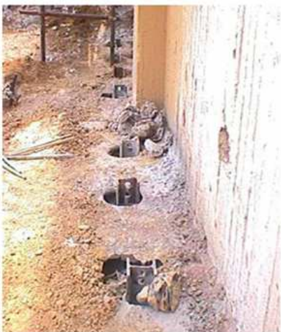
(ب) نصب پروفیل‌ها و بتن ریزی
