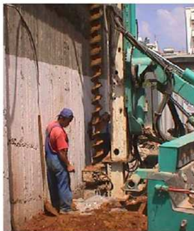
(الف) حفارها به وسیله دستگاه حفاری
